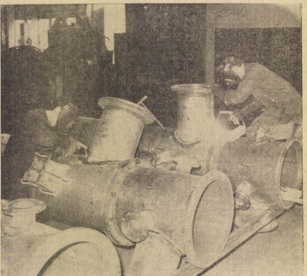
A napokban készült el a VEGYÉPSZER salgótarjáni gyáregységében a soproni gázmű részére az úgynevezett gázmosó- és hőcserélő berendezés. Értéke több mint egymillió forint. Képközpön: Oravecz István és Nyiri György hegesztők a hőcserélő befejező munkálatait végzik
